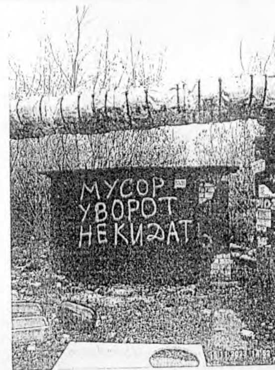
Демонтируемый объект: металлический гараж
