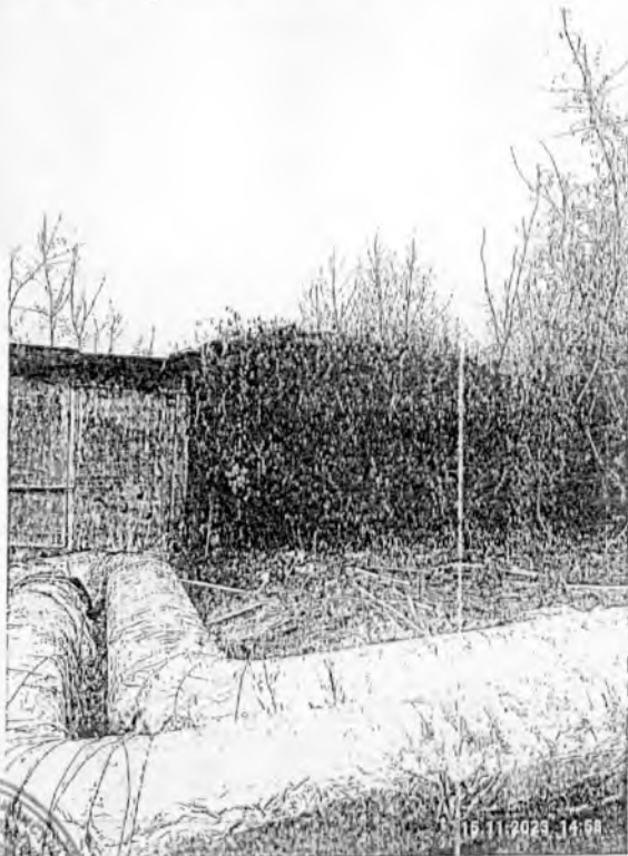
Демонтируемый объект: металлический сарай
