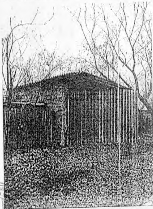
Демонтируемый объект: кирпичное строение
