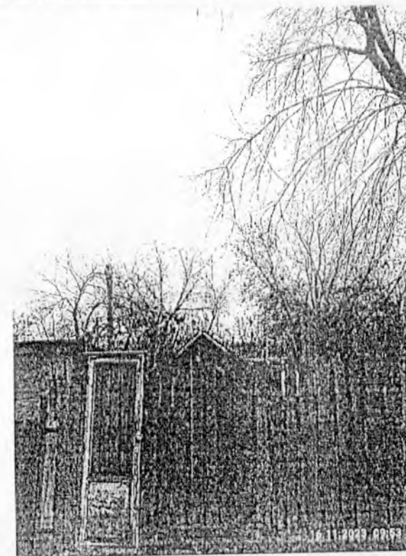
Демонтируемый объект: деревянный сарай
