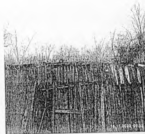
Демонтируемый объект: деревянный сарай
