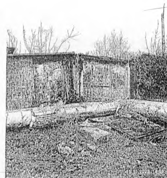
Демонтируемый объект: металлический сарай
