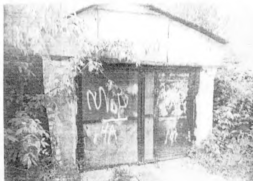
Демонтируемый объект: кирпичный гараж
