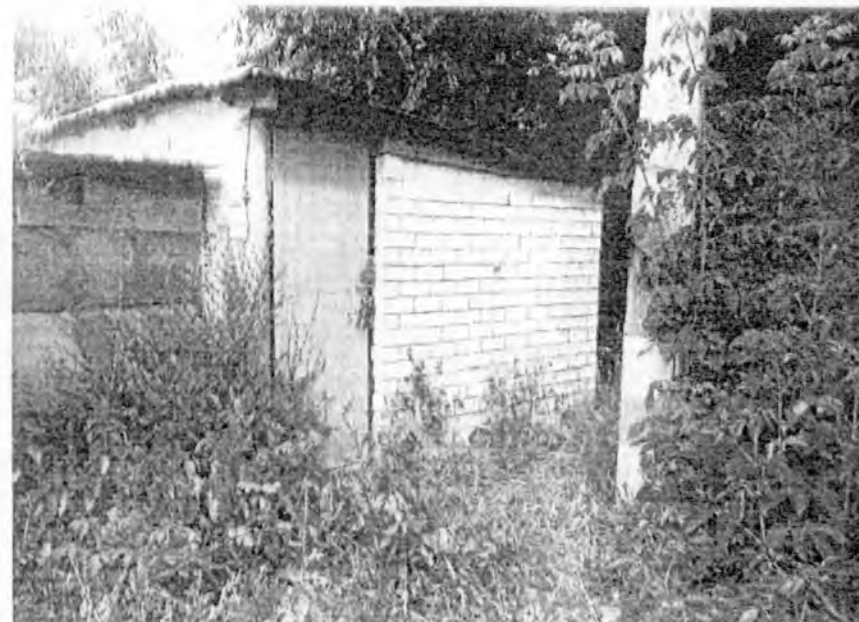
Демонтируемый объект: кирпичный сарай
