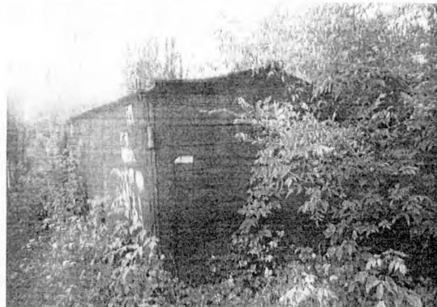
Демонтируемый объект: металлический гараж
