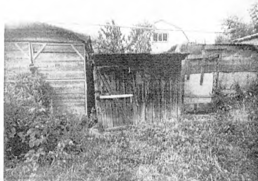
Демонтируемый объект: деревянный сарай
