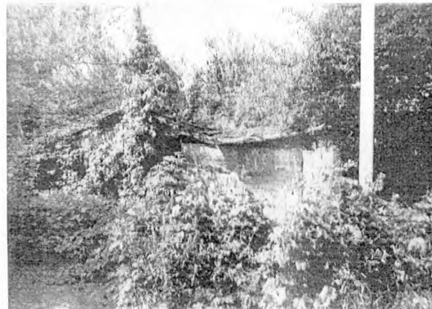
Демонтируемый объект: металлический гараж
