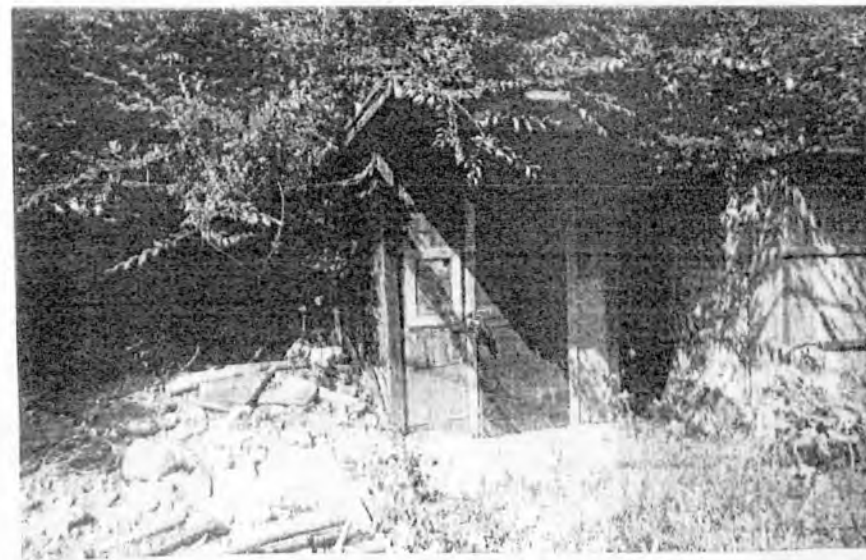
Демонтируемый объект: деревянный сарай
